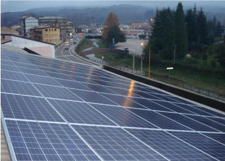
L'impianto fotovoltaico, da **44 kW**, è composto da 176 moduli in silicio policristallino Solarworld Sunmodule Plus SW250 ed inverter ABB.
