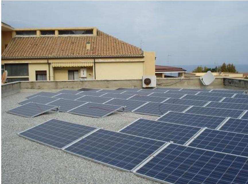
L'impianto fotovoltaico, da **14,5 kW**, è composto da 58 moduli in silicio policristallino Solarworld Sunmodule Plus SW250 ed inverter ABB.
